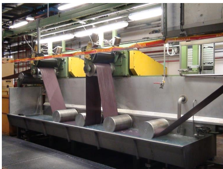
Photo : vue d'une des machines
